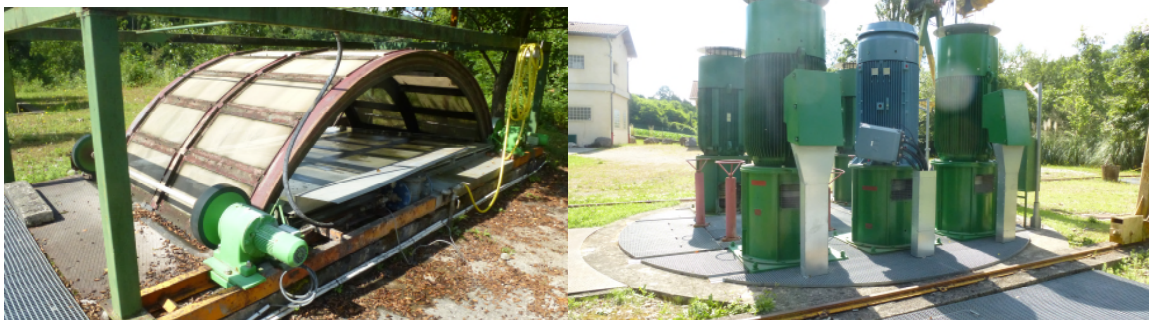
Vues de la station de pompage sur l'Isère (filtre et pompes de surface)
